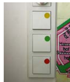
Lichtschalter mit Farbpunkten: rot steht für die Fensterreihe, gelb Mittelreihe, grün Wandseite
