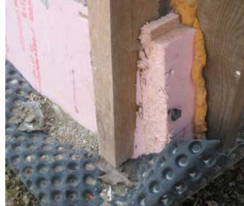
links: Dämmung mit Holz, Hanf, Schilf und Lehm; rechts: Dämmung mit Polystyrol und Bauschaum
