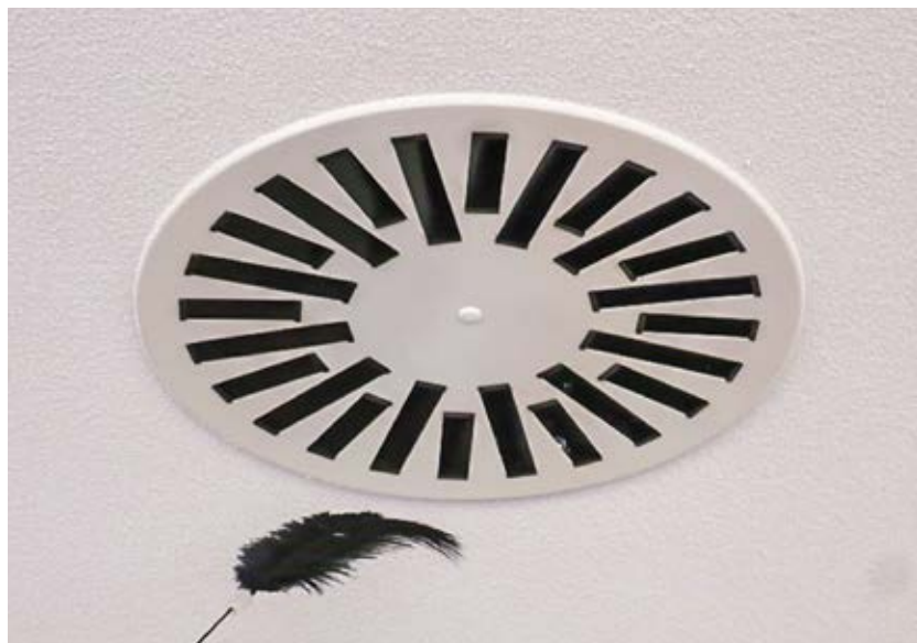
Am Lüftungsauslass wird mit einer Feder geprüft, ob Luft ausströmt.
