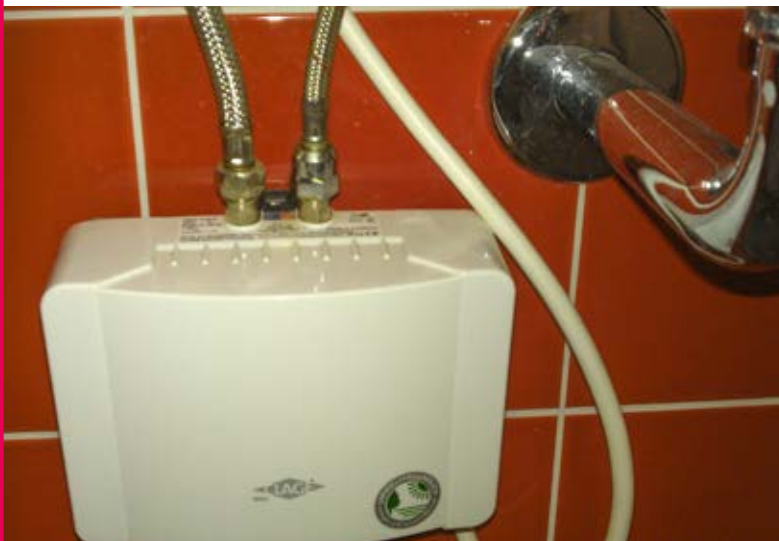
dezentrale, bedarfsabhängige Warmwasseraufbereitung mit Durchlauferhitzer
