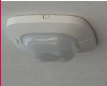
links: Präsenzmelder an der Decke eines WCs; rechts: Bedarfsgerechte Beleuchtung von Fluren mithilfe von Bewegungsmeldern
