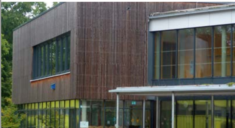
Außenansicht der Mensa der Grundschule am Stöckener Bach / Hannover
