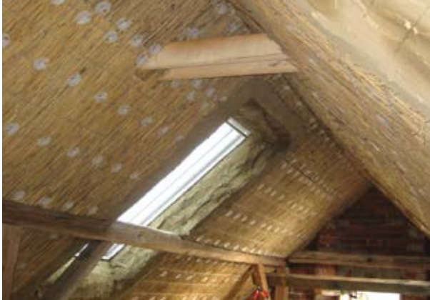
links: Dämmung mit Holz, Hanf, Schilf und Lehm; rechts: Dämmung mit Polystyrol und Bauschaum
