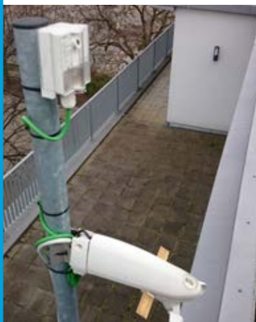
links: Diese unangeschlossene Wetterstation liefert keine Daten; rechts: Leibnizschule Tageslichtsteuerelement
