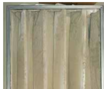
Links: Ein voller Filter behindert den Luftstrom und macht dadurch eine höhere Lüftungsleistung erforderlich. Rechts: Eigenkontrolle der Filter der RLT.
