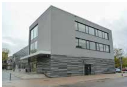
Passivhausgebäude erfordern eine angepasste Heizungsregelung verglichen zu konventionellen Bauarten.
