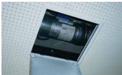
Defekte Volumenstromregler können häufig Ursache von Störungen sein.
