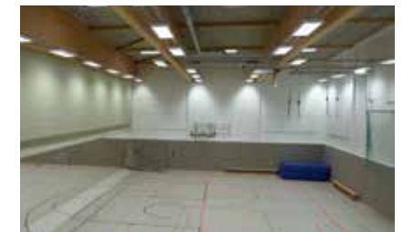
Überdimensionierte Beleuchtung für die Turnhalle
