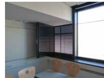
Fenster mit Wetterschutzgitter für Nachlüftung.
