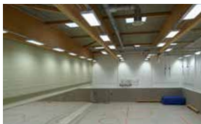
Sporthalle mit 30 kW installierter Anschlussleistung
