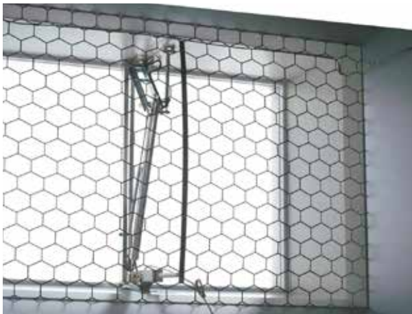
Good-Practice, Deckenluke mit Motorsteuerung und Schutzgitter.
