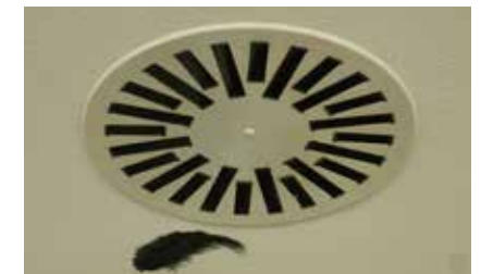
Die Quelle des Luftzugs kann durch eine an einem Stab befestigte Feder oder Faden leicht lokalisiert werden.
