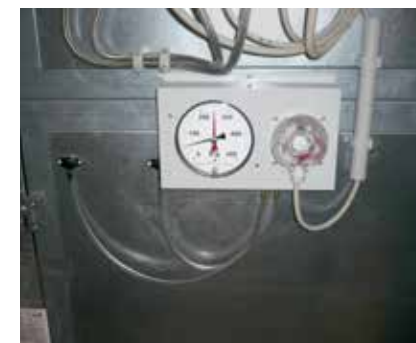
Links: Ein voller Filter behindert den Luftstrom und macht dadurch eine höhere Lüftungsleistung erforderlich. Rechts: Eigenkontrolle der Filter der RLT.
